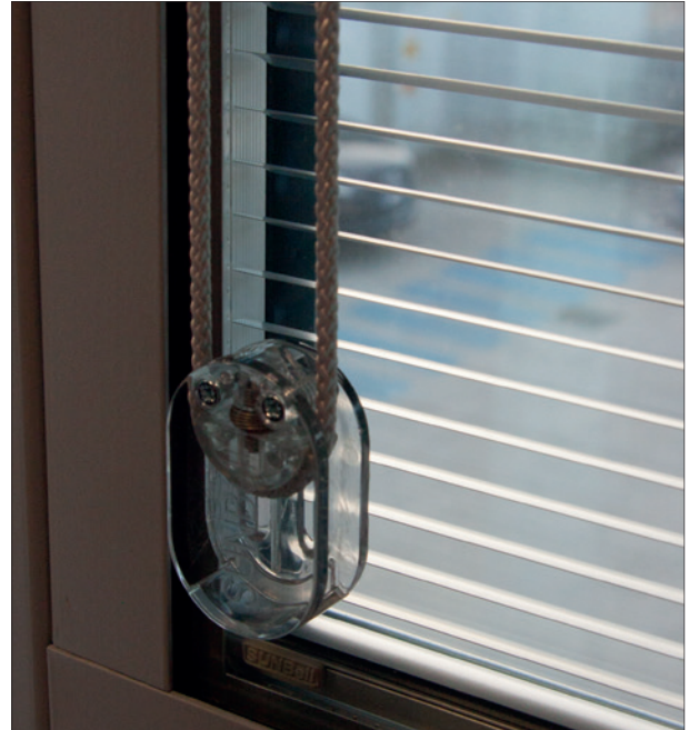
Particolare veneziana sistema di azionamento a corda
